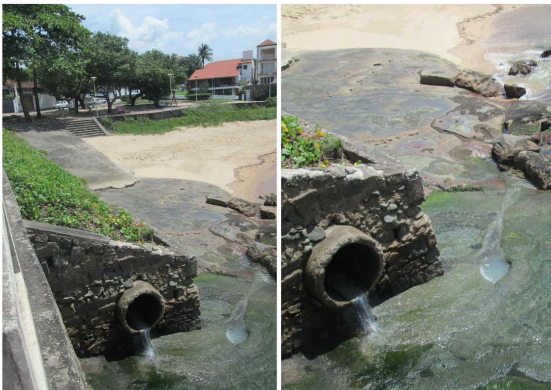
Figura 49. Provável lançamento clandestino de esgoto doméstico na rede de drenagem pluvial, Ilha do Boi, APAM Baía das Tartarugas, Vitória/ES.
