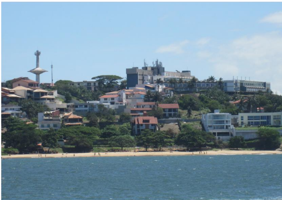
Figura 21. Usos residenciais na Ilha do Boi exemplificando as Zonas de Ocupação Restrita (ZOR) presentes na APAM Baía das Tartarugas, Vitória/ES.
