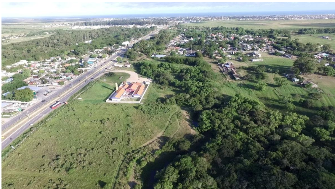
Figura 19. Ocupação urbana no bairro Bolaxa, às margens da RS – 734. Fonte: imagem captada por Kahuam Gianuca.
