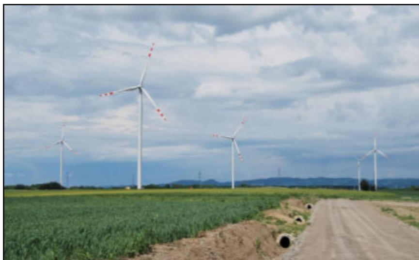
Figura 8 – Acesso construído para Parque Eólico em Rymanów Fonte: Cjrwind, 2014c.
