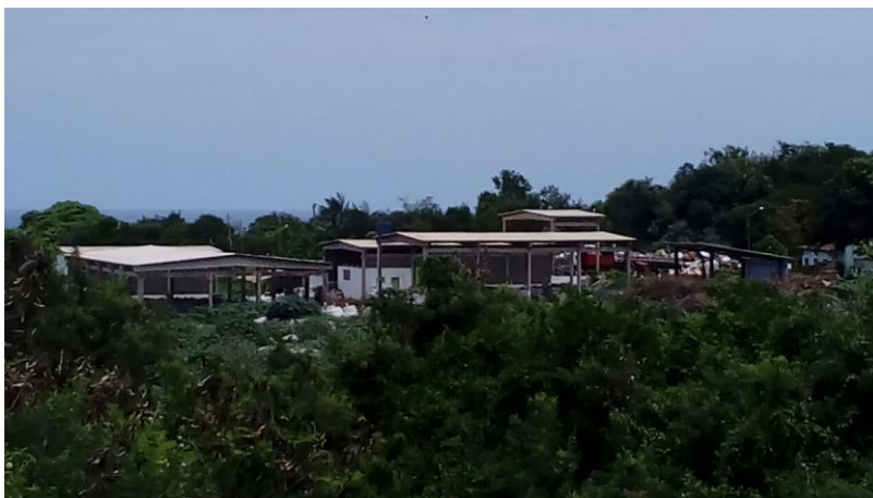
Figura 16. Vista da usina a partir da única estrada principal (BR-363), próximo ao aeroporto.
