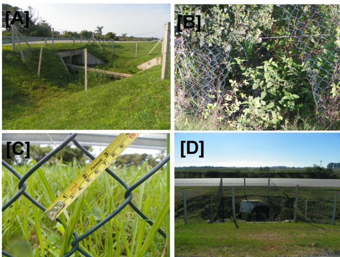
Figura 14: (A) Falta de tela no passa-fauna nº 3, localizado no Km 36+800; (B) Tela danificada no passa-fauna nº 5, localizado no Km 41+497; (C) Malha da tela instalada em toda a rodovia; (D) Duto de Drenagem instalado na Região 2, no Km 36+500.
