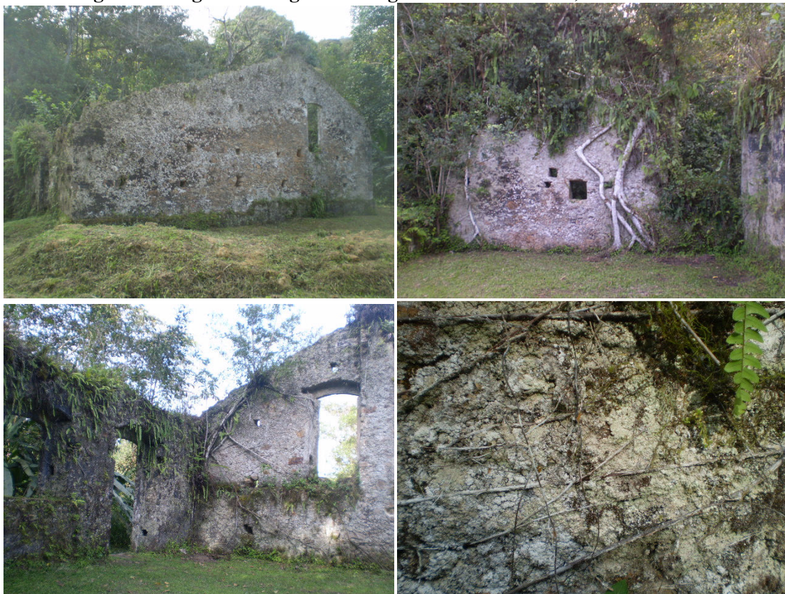
Figura 21/ Figura 22/ Figura 23/ Figura 24: Casa de Pedra, ruína do Mandira
