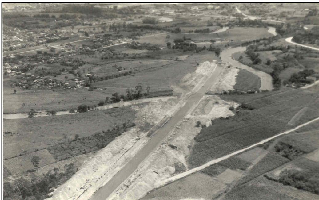
Figura 9: Retificação do rio Itajaí-Mirim na cidade de Brusque, em 1963. A obra fazia parte do plano de contenção e prevenção de enchentes, depois de três eventos catastróficos na década de 60. Efeitos da obra podem ser sentidos à jusante, na cidade costeira de Itajaí, que recebe suas águas em confluência com o Itajaí-Açu. Fonte: Parente (2008).
