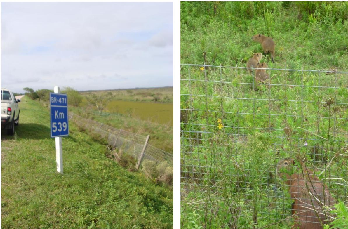
Figuras 17 e 18 – Trecho do SPF localizado no Setor 1, com telamento danificado devido a acidente e, onde os animais conseguem acessar a rodovia.
