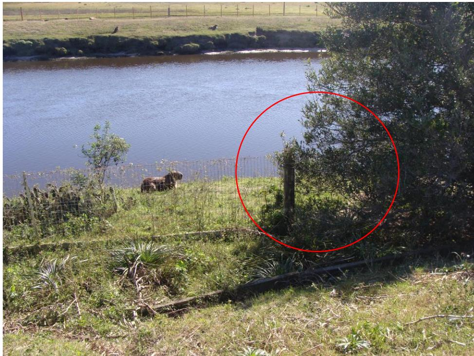
Figura 4 – Trecho do km 538 da rodovia BR471 na área do SPF, com presença de vegetação arbustiva e descontinuidade de reparos no telamento.
