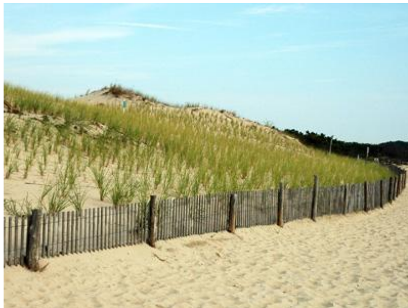
Figura 11 – Exemplo de recuperação de dunas com plantio de mudas e cercas para barrar o transporte de sedimentos. Fonte: DNREC (Delaware Department Of Natural Resources And Environmental Control 5 ).
