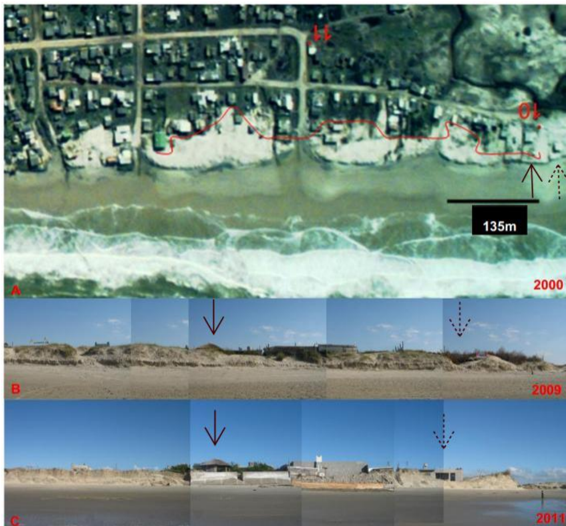
Figura 25 – Erosão das dunas costeiras no extremo norte da orla urbanizada do balneário do Hermenegildo, provavelmente por efeito do enrocamento da orla urbanizada ao sul. Figuras A, B e
