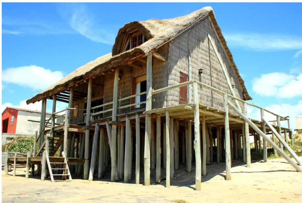
Figura 13 - Exemplo de casa adaptada para a erosão costeira, por meio de elevação da mesma com pilares de madeira. Foto de Pedro Pereira em Aguas Dulces, Uruguai.
