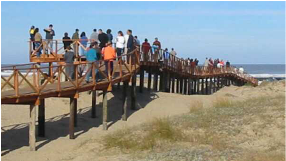
Foto 8: Passarela - trilha interpretativa - construída para inibir a passagem de pedestres pelas dunas - subtrecho 3. (Fonte: Arquivo Fotográfico do NEMA)
