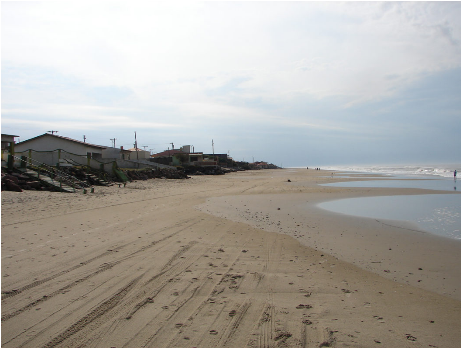
Foto 31: Vista geral do Balneário do Hermenegildo com detalhe do processo erosivo - Região Sul. (Fonte: Arquivo Fotográfico do NEMA)
