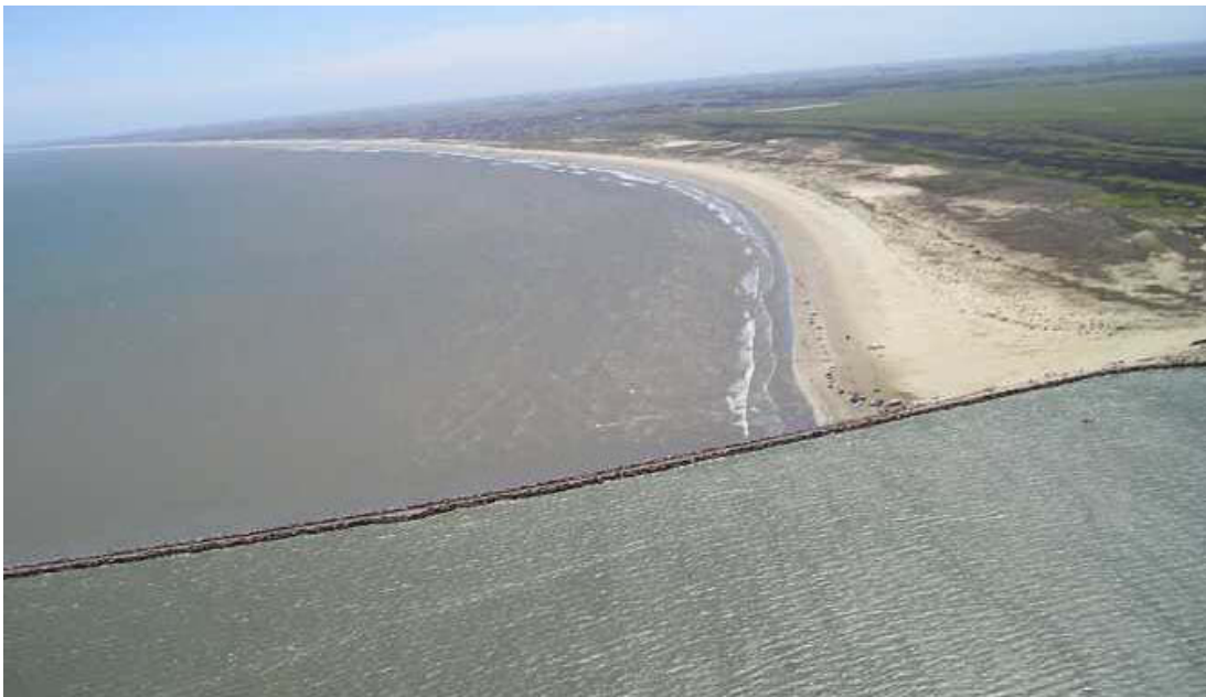
Foto 4: Vista aérea da base do Molhe Oeste em direção ao Cassino - subtrecho 2. (Fonte: Arquivo Fotográfico do NEMA)
