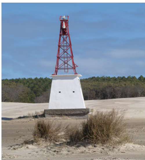
Foto 25: Faroleta Verga com maciço de Pinus ao fundo. Região Norte. (Fonte: Arquivo Fotográfico do NEMA)
