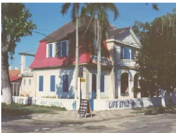
Figura 19a: Antigo Chalet destruído.
