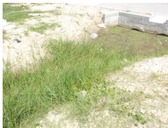
Figura 12 b: Falta de manutenção.
